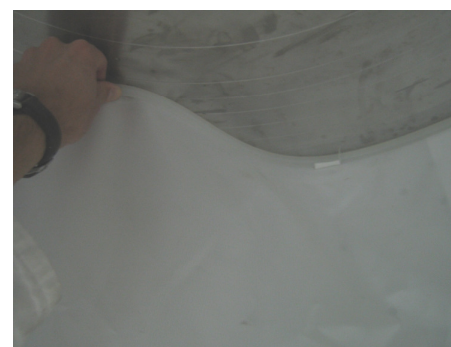
mise en place du cerclage arrière
